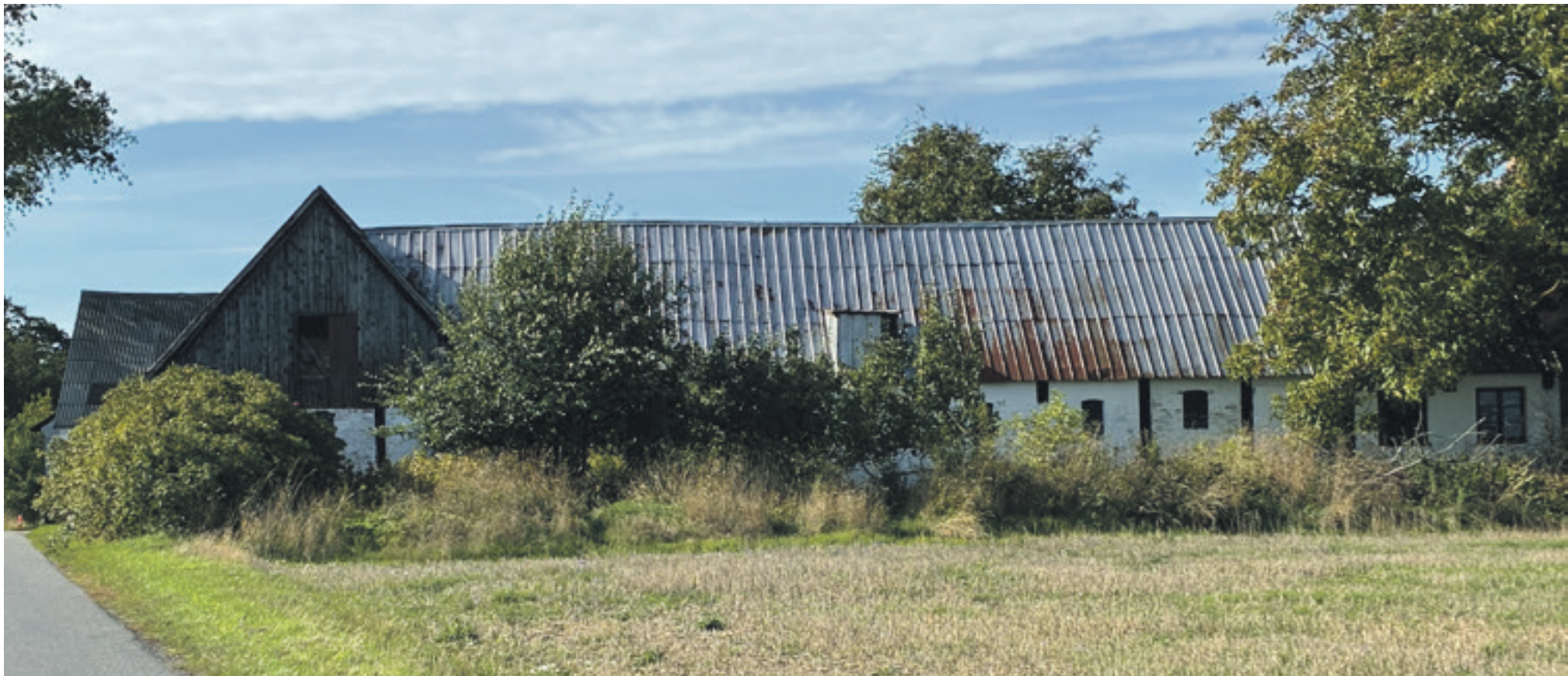
Nørregård på Nørregårdsvej, som blev brugt til skole, mens man ventede på at den nye (ældste) skole blev færdig på Røvej
